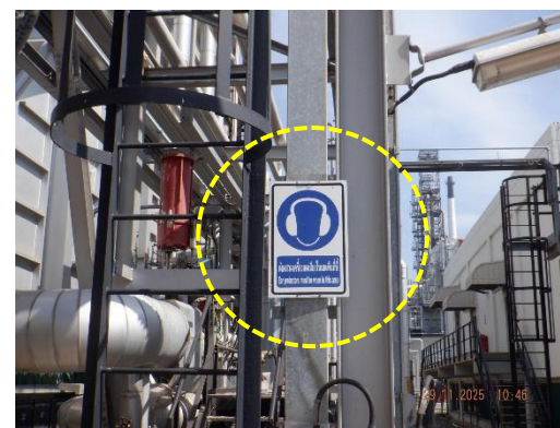
รูปที่ 2-4 ติดตั้งป้ายเตือนสวมใส่อุปกรณ์ป้องกันอันตรายส่วนบุคคล สำหรับผู้ปฏิบัติงานในบริเวณที่มีเสียงดังเกิน 85 เดซิเบล (เอ)
