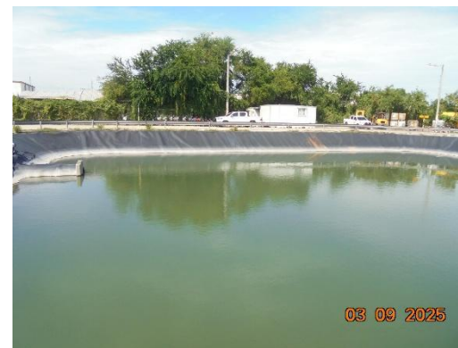
รูปที่ 2-8 บ่อพักน้ำฝนปนเปื้อน ขนาด 1,324 ลูกบาศก์เมตร (T-86103)
