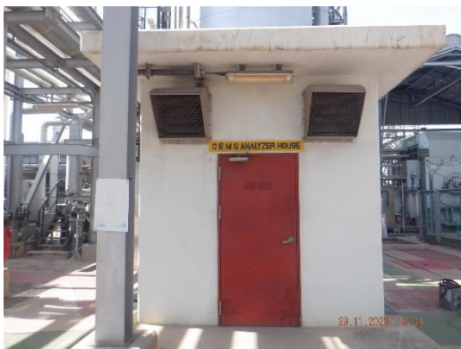
รูปที่ 2-1 การติดตั้งระบบตรวจวัดอากาศเสียแบบต่อเนื่อง (CEMS) ที่ปล่อยระบายอากาศของ HRSG
